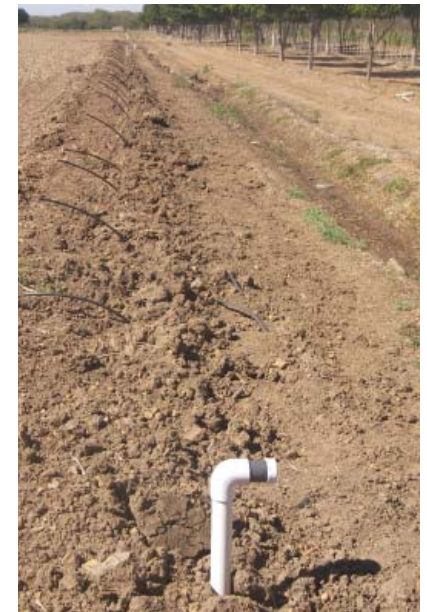
Figura 6. Sección de terreno preparado con el sistema de riego presurizado ya instalado.
