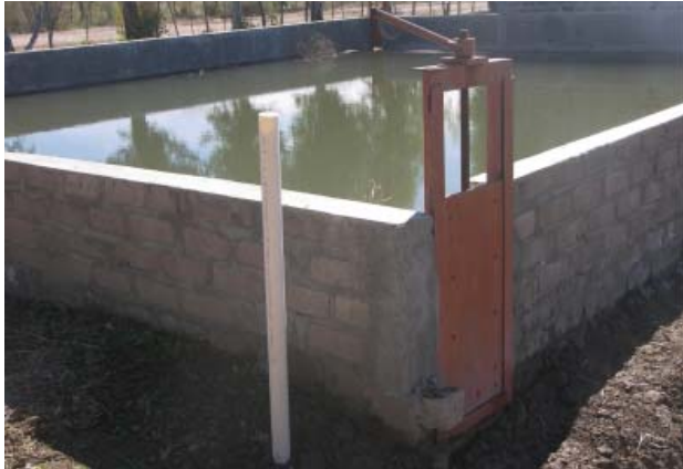
Figura 15. Depósito de agua para alimentar el sistema de riego por goteo y el sistema de riego por gravedad.
